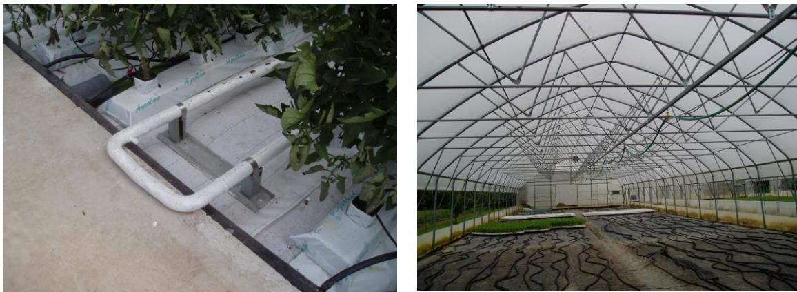
Slika 19 a i b: Cijevni razvod toplovodnog grijanja (lijevo) i podno grijanje (desno)
