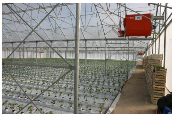
Slika 17: Samostalna jednica za zagrijavanje toplim zrakom loživim uljem
