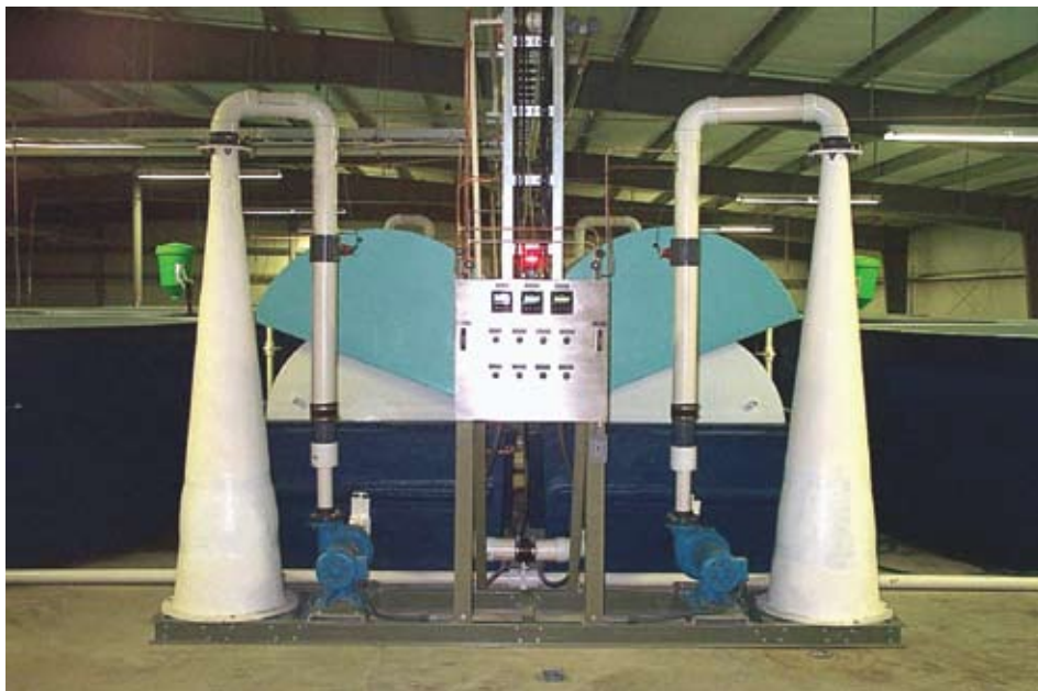
Slika 2. Komponente jedinice za pročišćavanje vode u reciklacijskom uzgojnom sustavu
