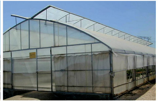
Slika 5. Plastenik opremljen bočnom i krovnom ventilacijom
