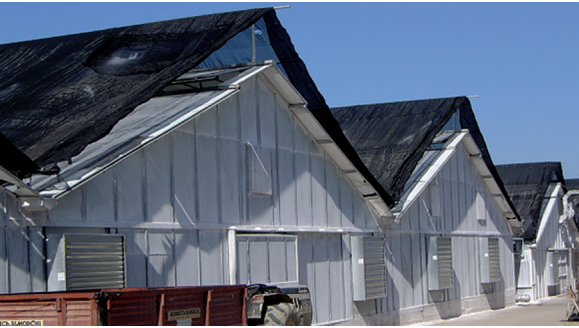
Slika 4. Zasjenjivanje mrežom i bojanje staklenika u svrhu snižavanja temperature
