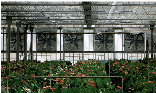
Slika 6. i 7. Ventilatori i porozna ploča za adijabatsko hlađenje
