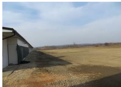
Slika 7. Prilazni put lokaciji sa lokalnog puta
