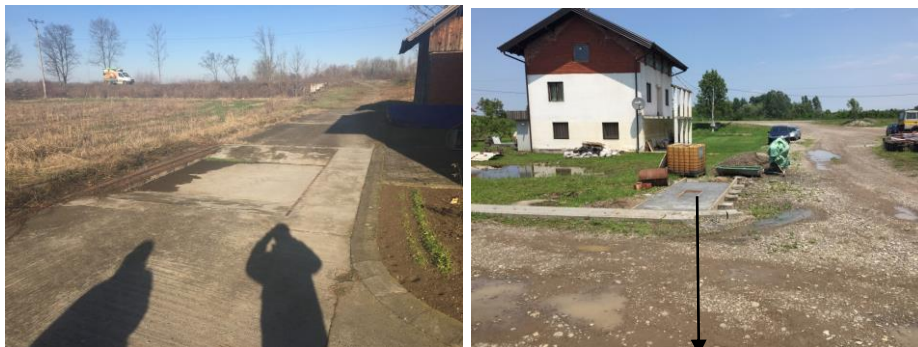
Stara dezobarijera koja nije u funkciji Prostor na kome je počela izgradnja pješačke i kolske dezobarijeru
