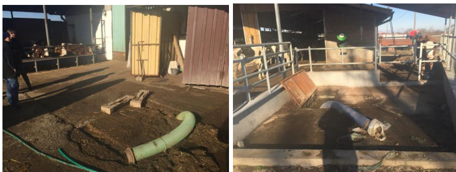
Šahtovi za pražnjenje osočnice
