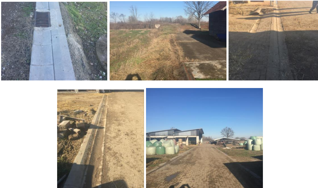
Površinski otvoreni kanali
