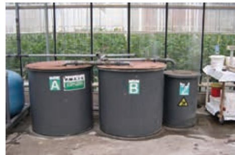
Sustav dva spremnika s manjim spremnikom za prilagođavanje pH
