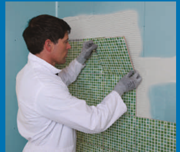
Postavljanje pločica na Rigips Glasroc H.
