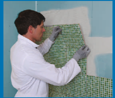
Postavljanje pločica na Rigips Glasroc H.
