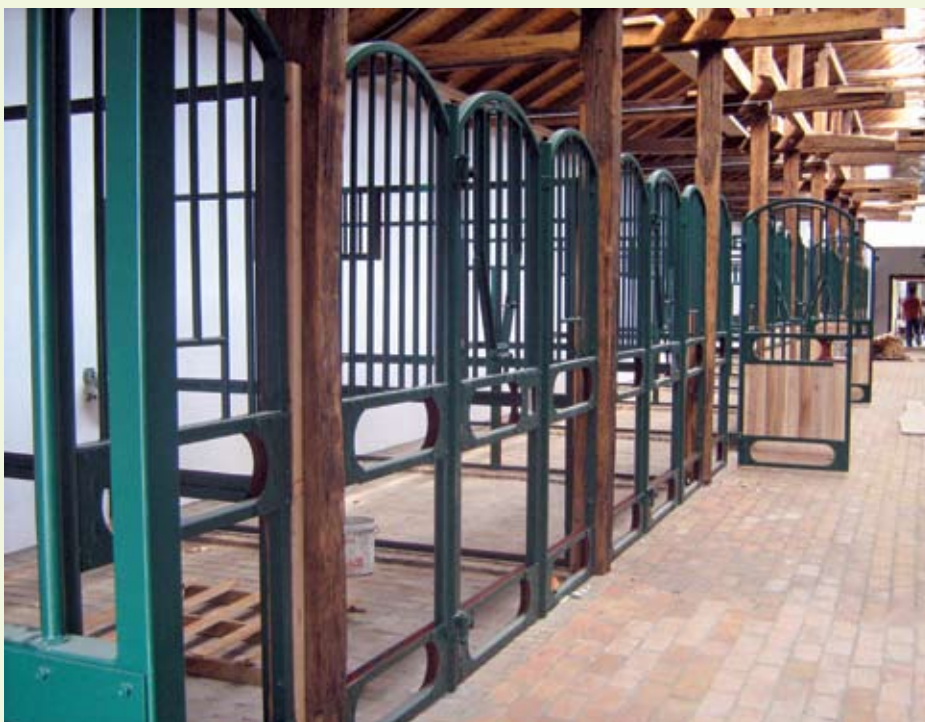
Radovi na opremanju konjušnice i bokseva
