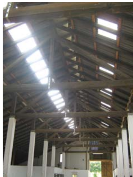
Krovište koje je u cijelosti u funkciji ventilacije i prozračivanja, kao i prirodnog osvjjetljenja
