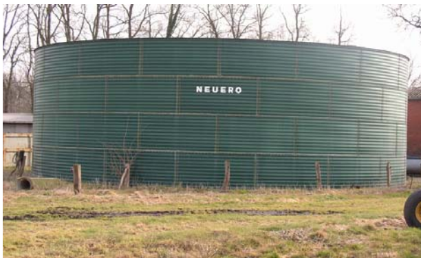
Nadzemni spremnik gnojovke
