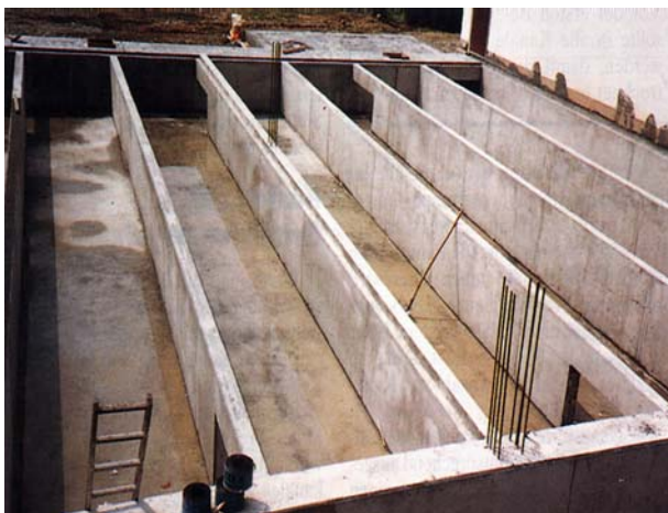
Kanali za skladištenje gnojovke ispod staje („slalom sistem“)
