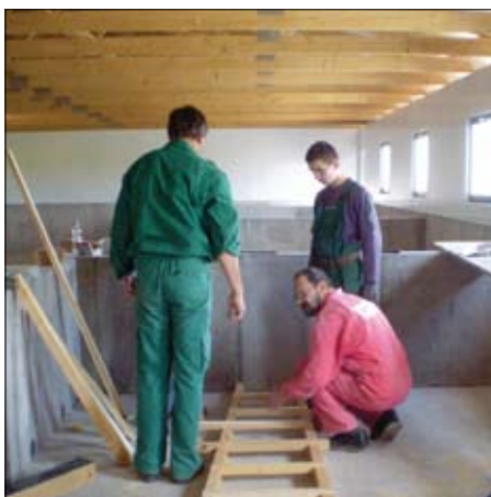
Iskusna i stručna ekipa brzo izvodi radove na montaži opreme
