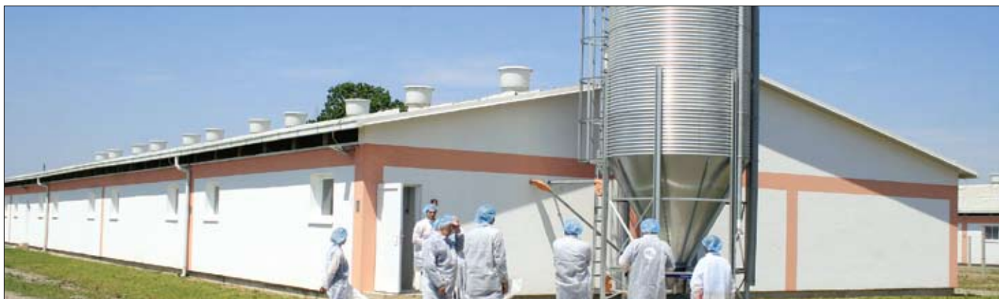
Metalni silos na farmi ima kapacitet od 35 metara kubnih, visine 8,52 m, širine 2,75 m sa 6 nogu, a puni se pneumatski
