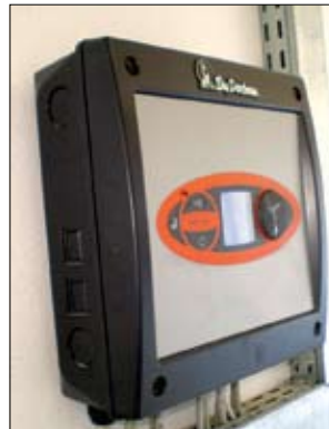
Kompletan sistem ventilacije je upravljn preko kompjutera MC 135 u koji se mogu unijeti parametri za svaki odjeljak farme
