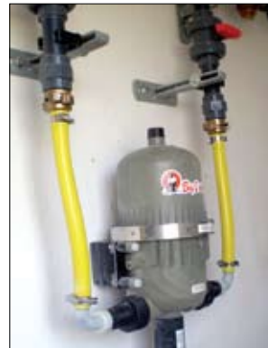
Sistem napajanja se sastoji od medikatora za ubacivanje lijekova u vodu za životinje, pojilica sa posudom, filtera, kuglastih ventila, manometara
