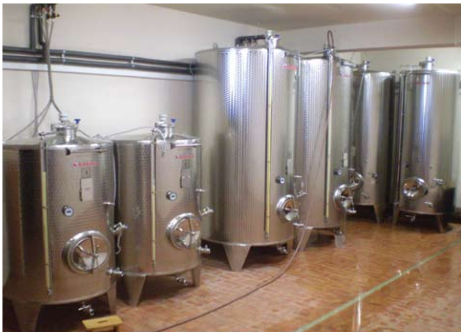
Inox oprema u novom podrumu
