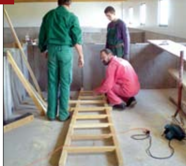
Izgradnja boksova u krmačarniku
