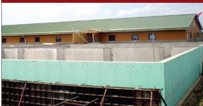
Vanjski izgled krmačarnika. Do njega je započeta gradnja tovljišta.
