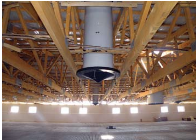
Krovište i ventilacija u objektima
